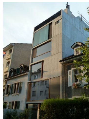
In diesem Beispiel wurde das Gebäude aufgestockt und damit verdichtet.
